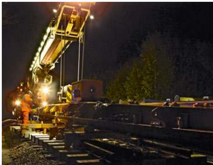
↑ Instalowanie zwrotnicy
