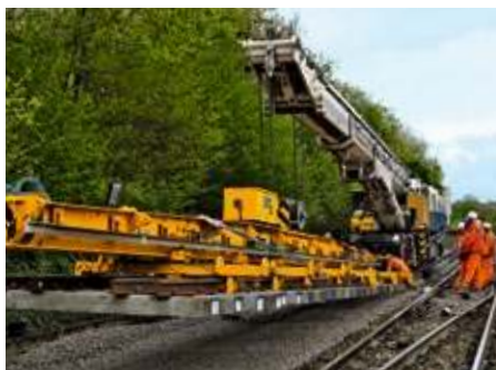
↑ Montaż za pomocą żurawia Multitasker
