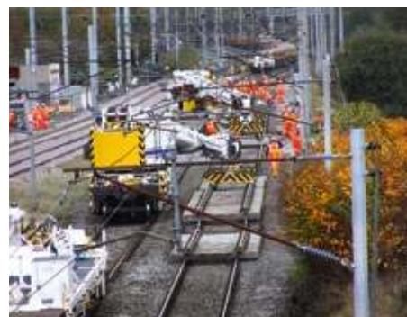
↑ Montaż za pomocą dwóch żurawi
