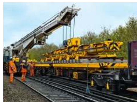
↑ Ustawienie wysięgnika żurawia nad sekcją
