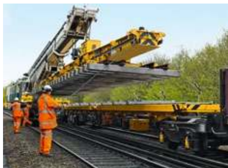
↑ Przenoszenie sekcji na miejsce montażu
