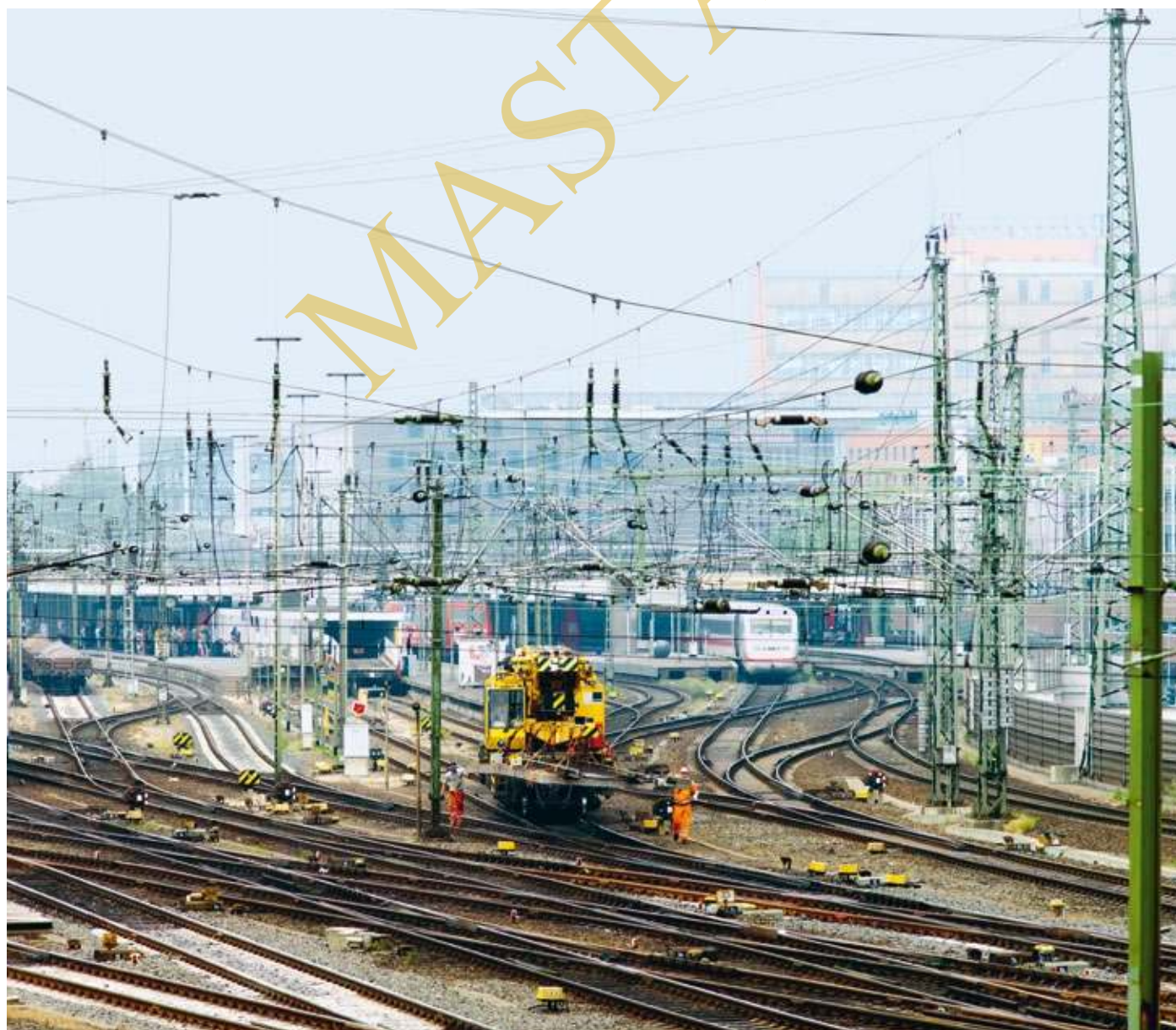
↑ Duża ilość rozjazdów i zwrotnic na stacji kolejowej: centrum rozrządowe
